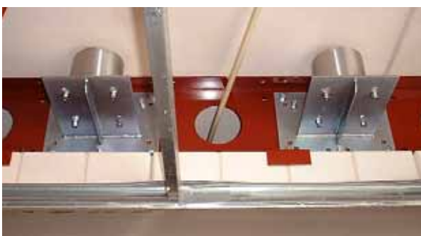
制振装置設置例
